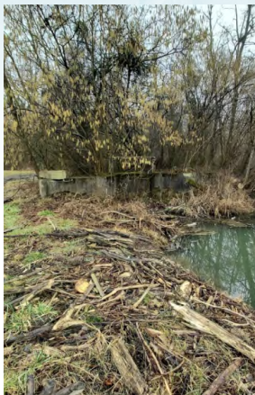
2. sz. kép: ÉDÁSZ Üzemvízcsatorna beeresztő zsilip
