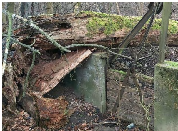
6., 7. sz. kép: Csavarorsós szakaszduzzasztó tiltó
