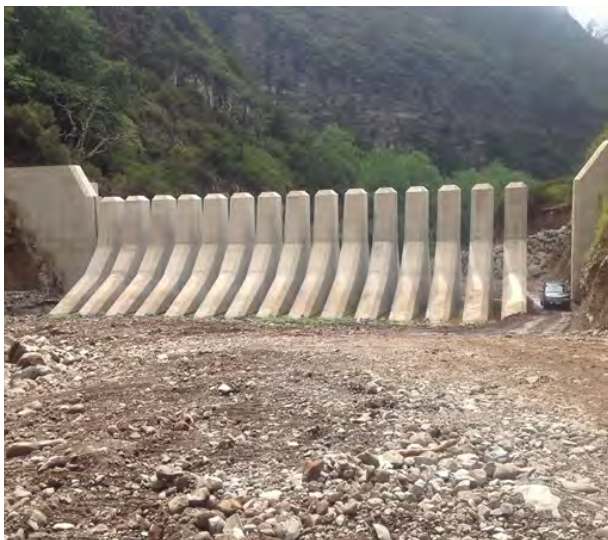
3. ábra: Réses hordalékfogó műtárgy Portugáliában (Forrás: www.lcwconsult.com )
