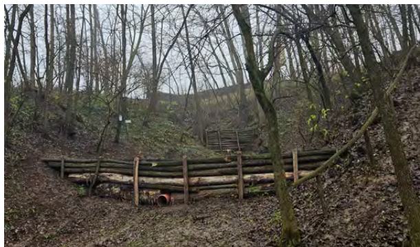
6. ábra: Püspökszilágyon megvalósult lefolyásslassító objektumok (Forrás: Gyenis Olivér)
