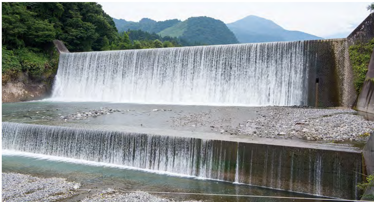
2. ábra: Zárt, impermeábilis sabo gát (Forrás: toyama-bunkaisan.jp)
