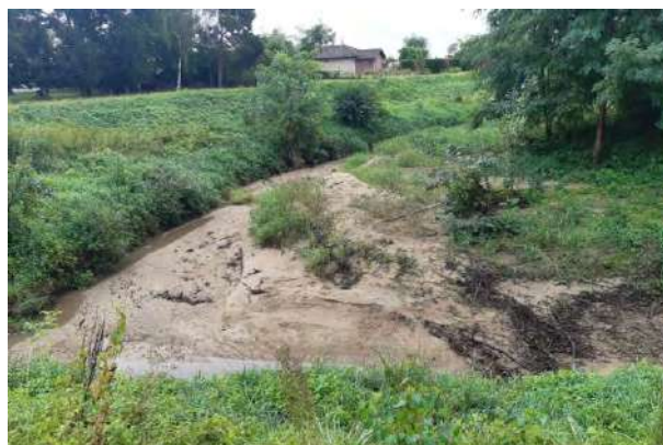
6. kép: Pornóapátiban feliszapolódott hallépcső (Forrás: NYUDUVIZIG archív)
