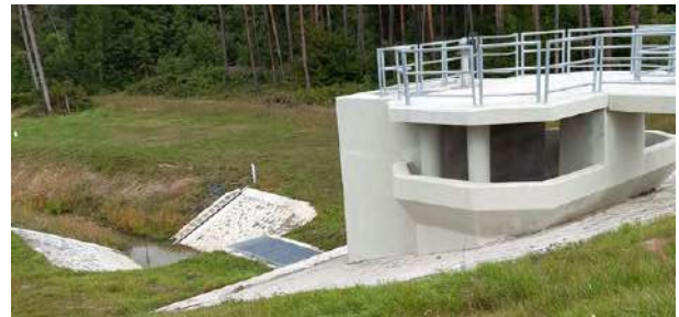
12. ábra: A Rönöki tározó vízszintszabályozó műtárgya
