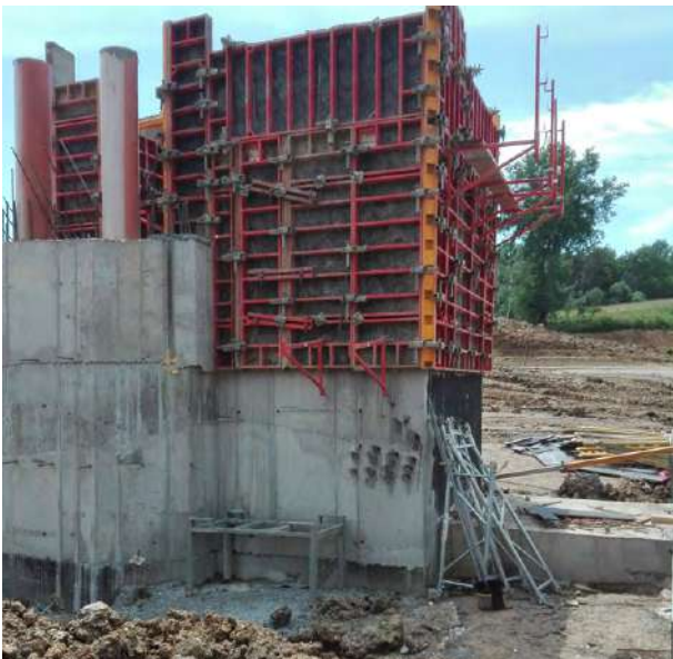
10. ábra A Rönöki tározó vízszintszabályozó műtárgya kivitelezés alatt
