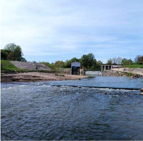
5. fotó: A szentgotthárdi erőmű és duzzasztómű alsó bögéjében lerakódott hordalék (fotó: Kapitány Szabolcs)
