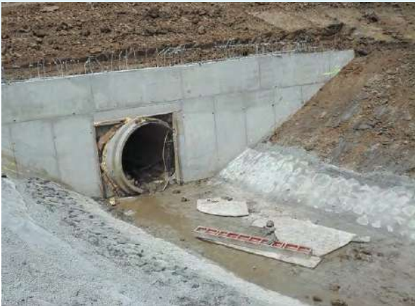
7. és 8. ábra: A Rönöki tározó völgyzáró gátja kivitelezés alatt (Forrás: NYUDUVIZIG archív)
