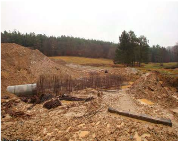
10. ábra A Rábagyarmati tározó vízszintszabályozó műtárgya kivitelezés alatt (Forrás: NYUDUVIZIG archív)
