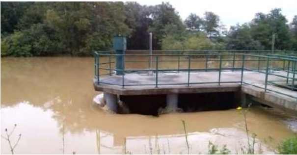
6. ábra: Kebele-árvíztározó a 2014. szeptemberi árvízi üzem alatt
