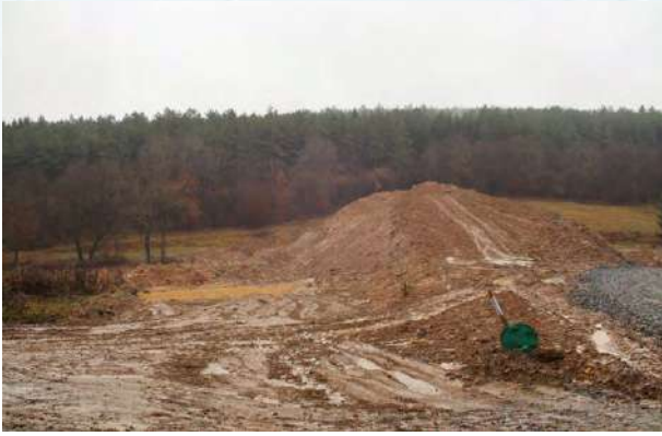
7. és 8. ábra: A Rábagyarmati tározó völgyzárógátja kivitelezés alatt (Forrás: NYUDUVIZIG archív)
