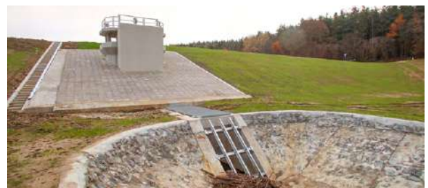
12. ábra: A Rábagyarmati tározó vízszintszabályozó műtárgya (Forrás: NYUDUVIZIG archív)
