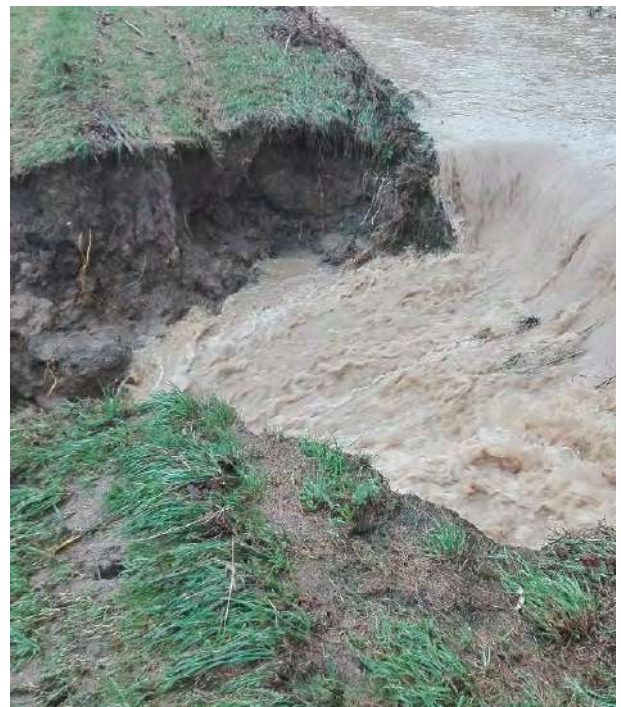
Keszthely – Hévíz ök. út. alvíz, bal parti elöntés, jobb parti depóniaszakadás
