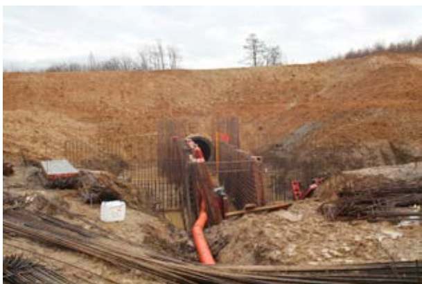
10. ábra: A Cákai tározó vízszintszabályozó műtárgya kivitelezés alatt (Forrás: NYUDUVIZIG archív)
