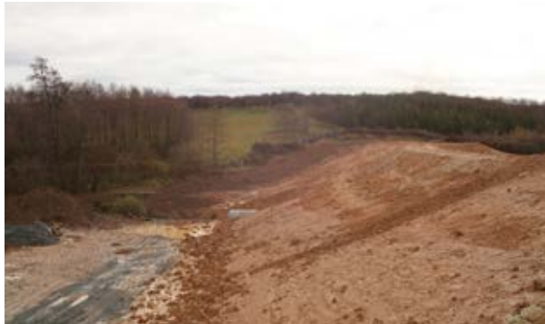
7. és 8. ábra: A Cáki tározó völgyzárógátja kivitelezés alatt (Forrás: NYUDUVIZIG archív)
