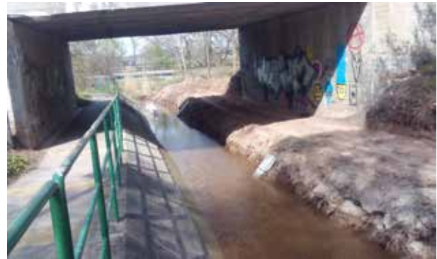
Lovasi-Séd burkolatfelújítási munkák – eredeti állapot
