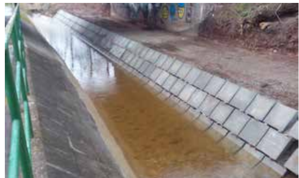
Lovasi-Séd burkolatfelújítási munkák – mederburkolat rekonstrukciója
