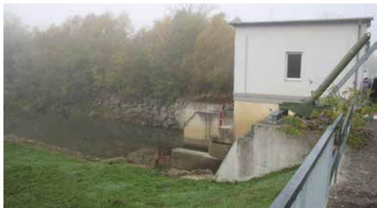
A felújított erőmű alvívcsatornája Pornóapátiban
