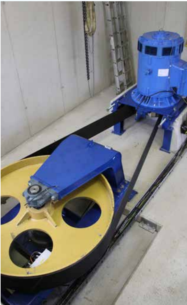
A szentpéterfai erőmű Francis-turbinával hajtott generátora
