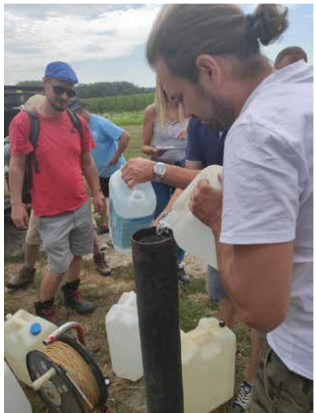
Kút nyeletési próba
