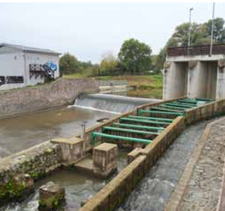
Az új duzzasztó a hallépcsővel és a csónakcsúszdával
