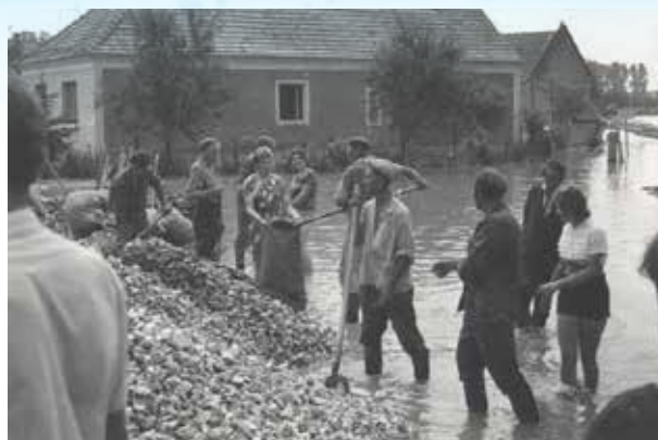
1. fotó: Borsfai-patak, Tótszerdahely. Zsákok töltése zúzott kővel
