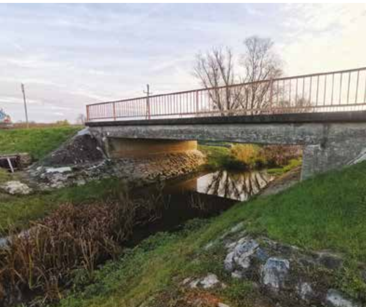
2. kép 6811 sz. közúti híd alvízi oldal békeidőben
