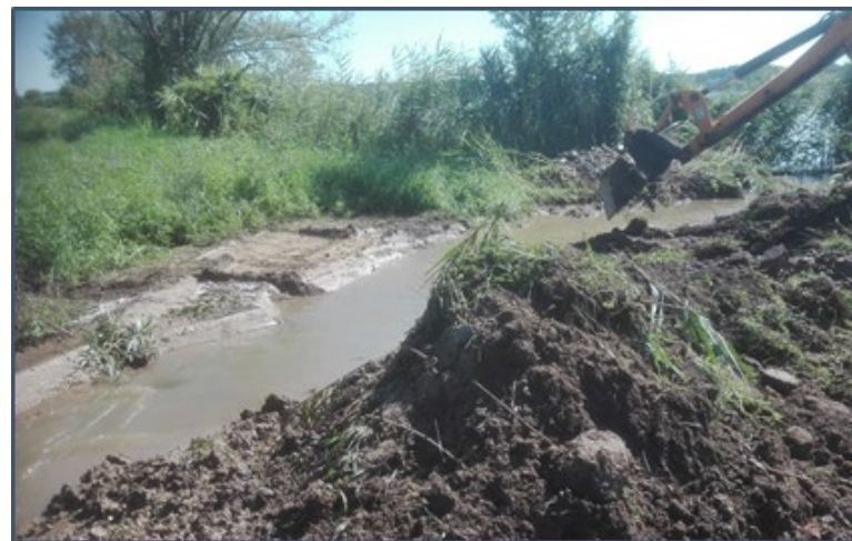
25. ábra: A halastórendszer tehermentesítése ideiglenes vészárasztó kialakításával (Forrás: Horváth Tívdar Zalaegerszeg, NYUDUVIZIG)
