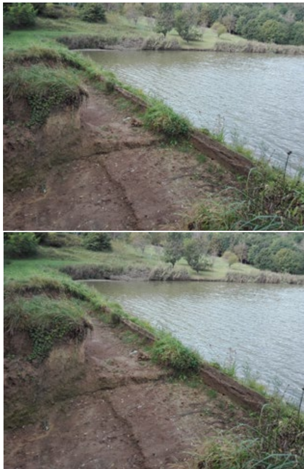
12. ábra (felül): Völgyzárógát korona
