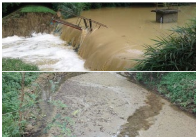
9. ábra (felül): Szakadási hely - II. számú víztározó 10. ábra (alul): Partélig feltöltött meder
