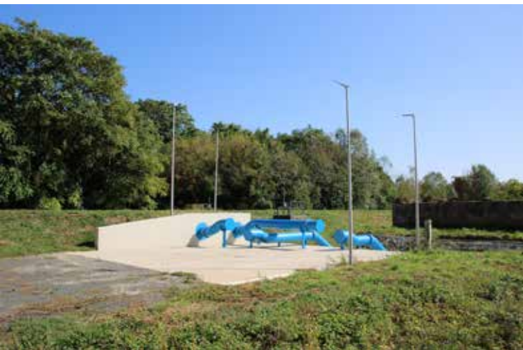
Az Aranyos-éri zsilip szivattyúállása
