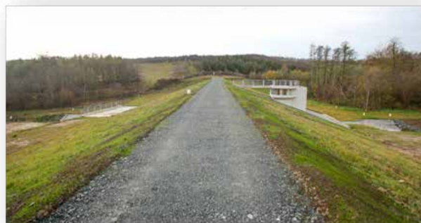
7. kép: A tározó töltése a műtárggyal
