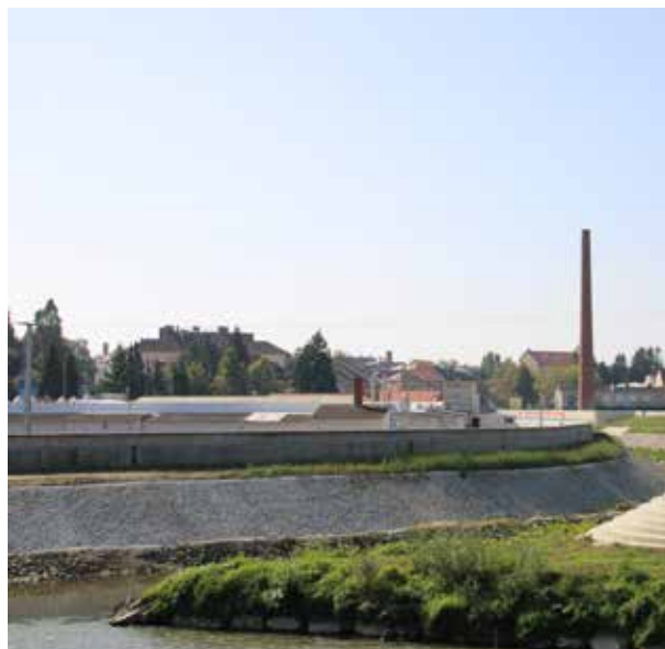
A Rába rézsűburkolata a Lapincs-torkolatnál (Szentgotthárd)
