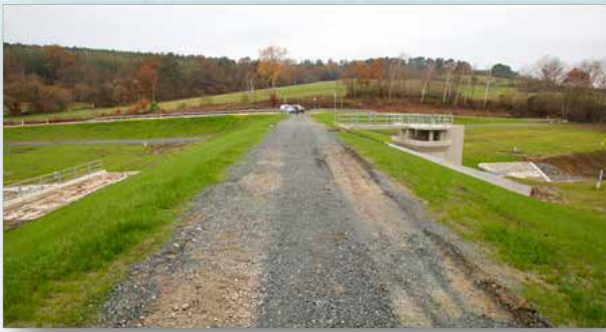
13. kép: A tározó töltése a műtárggyal
