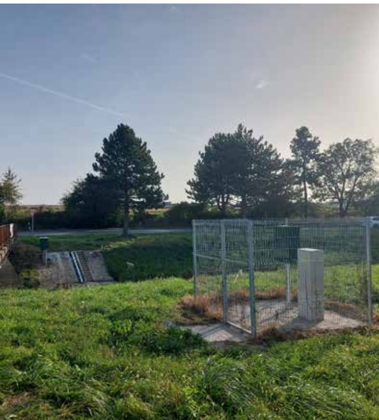
Uszadékterelő műtárgy építése és a csillapítómedence felújítása a Lukácsházi árvízcsúcscsökkentő tározó vízszintszabályzó műtárgyánál
