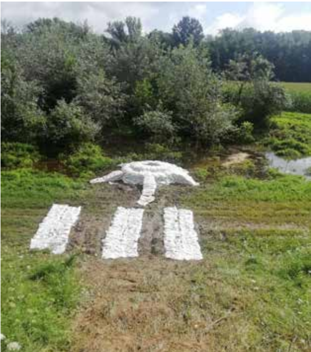
Buzgár elfogása és bordás megtámasztás a Mura bal parti töltés előterében (Fotó: Mikolics Zoltánné)
