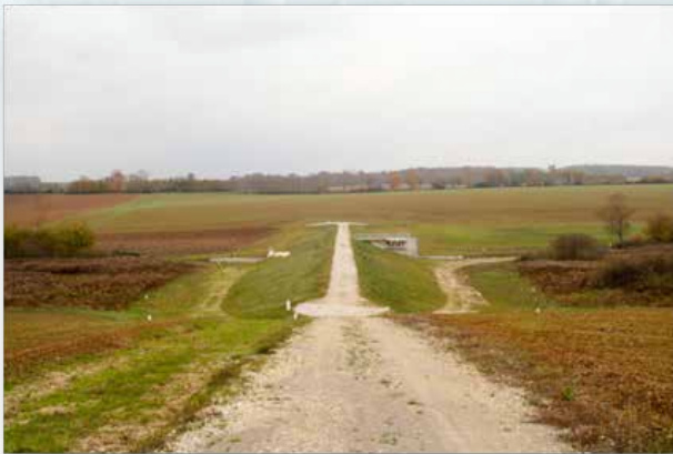
19. kép: A tározó töltése a műtárggyal
