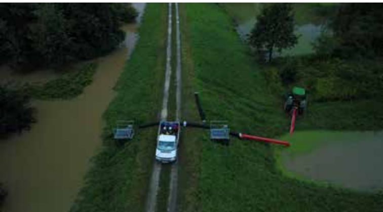
Szivattyú telepítése a Pinka bal parti védtöltésén (Fotó: Simon Zoltán)
